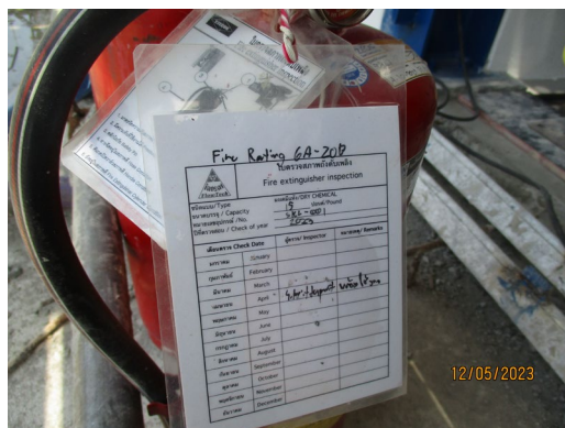
ภาพที่ 2-6 ป้ายแสดงการตรวจสอบอุปกรณ์ดับเพลิง
