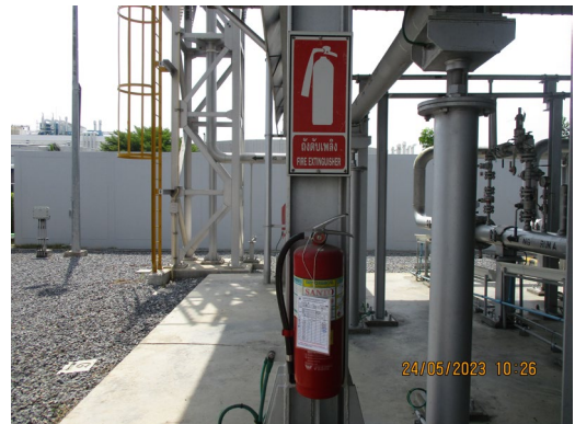
ภาพที่ 2-5 ถังดับเพลิงแบบผงเคมีแห้ง
