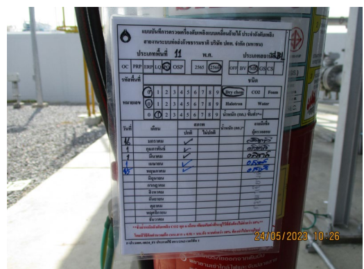
ภาพที่ 2-6 ป้ายแสดงการตรวจสอบอุปกรณ์ดับเพลิง
